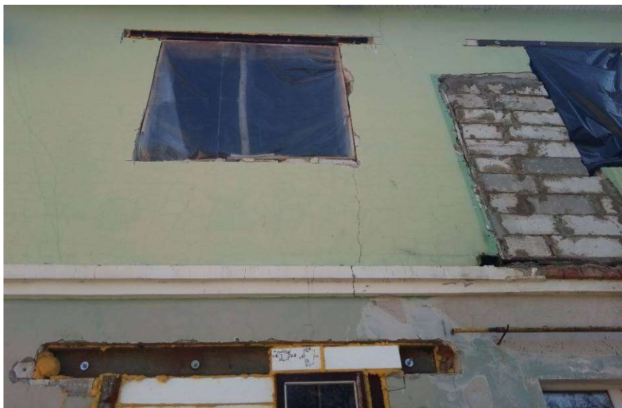
Рисунок 2 – Некоректне виконання перемичок з швелерів завищених профілів у тонких стінах
